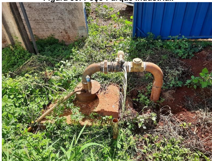
Figura 80: Poço Parque Industrial.
