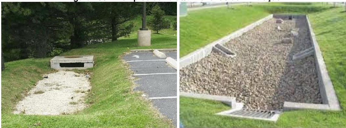
Figura 150: Exemplos de valas/trincheiras de infiltração.
