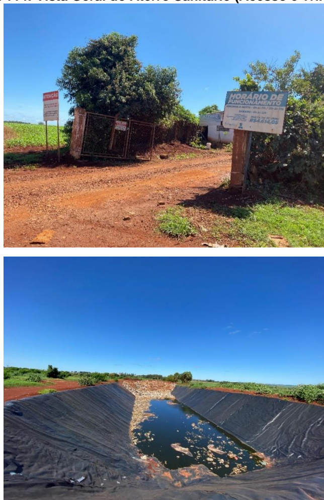
Figura 114: Vista Geral do Aterro Sanitário (Acesso e Trincheira)
