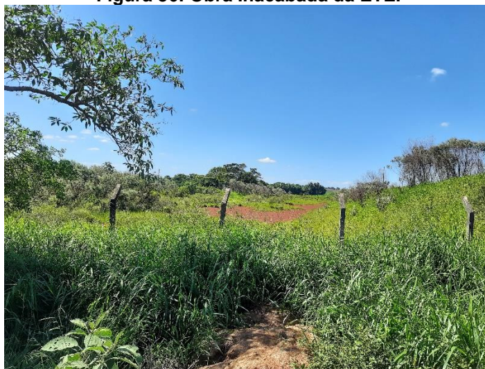
Figura 86: Obra Inacabada da ETE.
