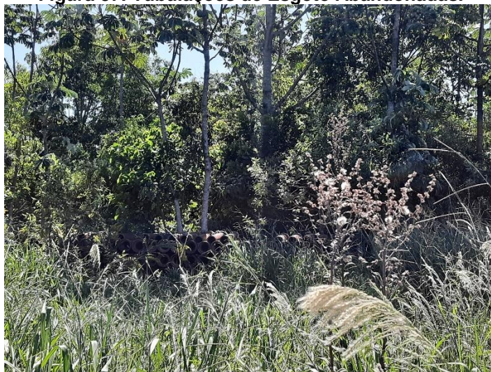
Figura 87: Tubulações de Esgoto Abandonadas.
