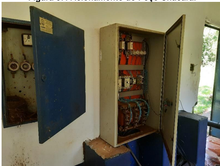
Figura 67: Acionamento do Poço Chácara.
