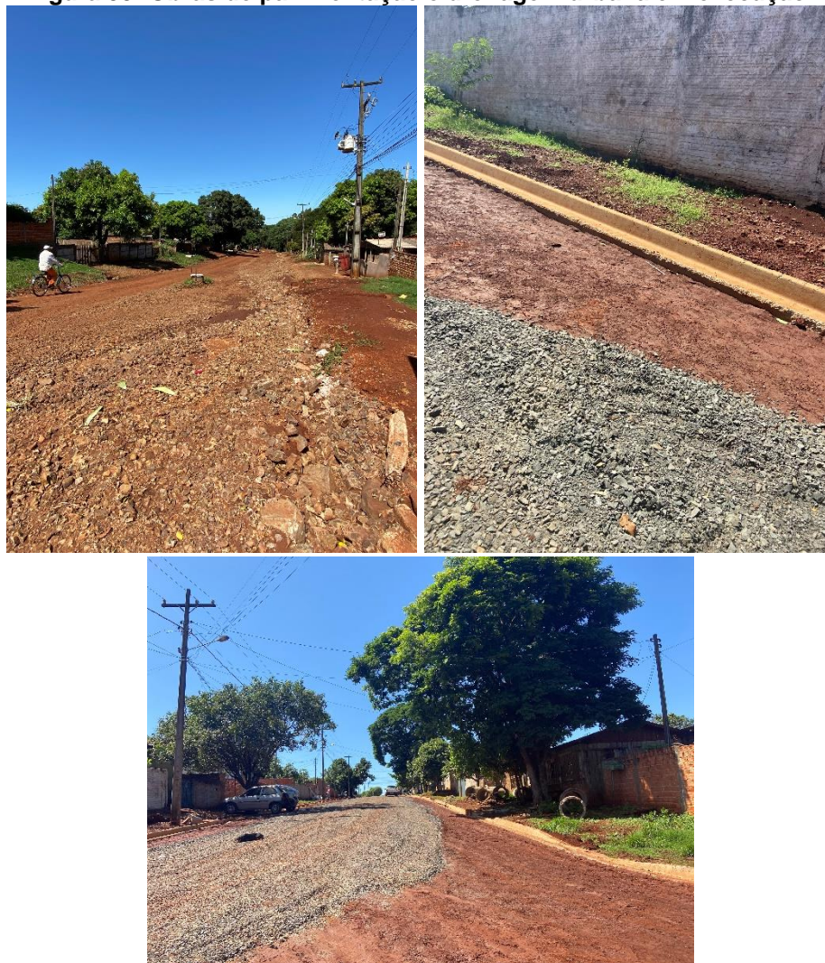
Figura 99: Obras de pavimentação e drenagem urbana em execução.
