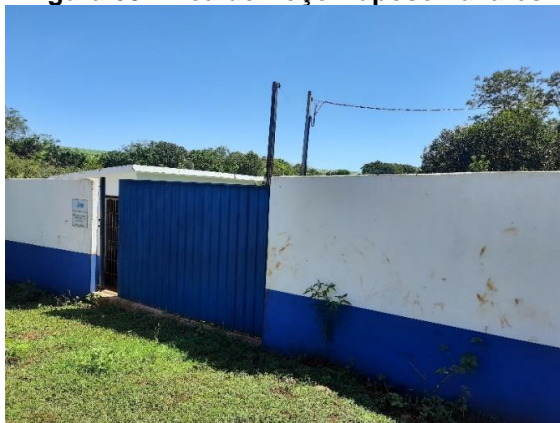
Figura 63: Área do Poço Raposo Tavares.
