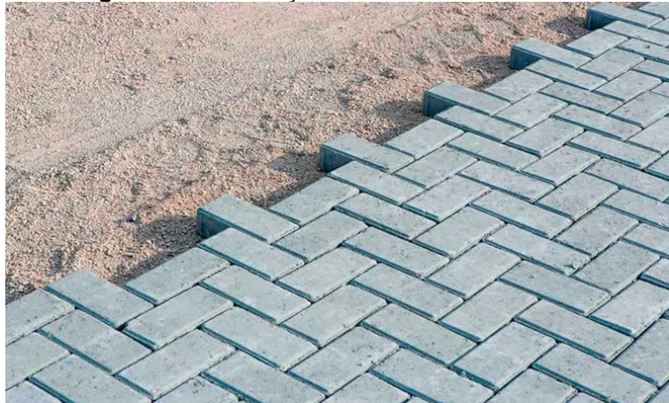
Figura 156: Instalação de blocos intertravados.
