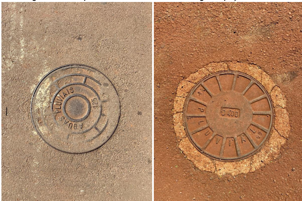
Figura 94: Exemplo de estruturas de microdrenagem – poços de visita.
