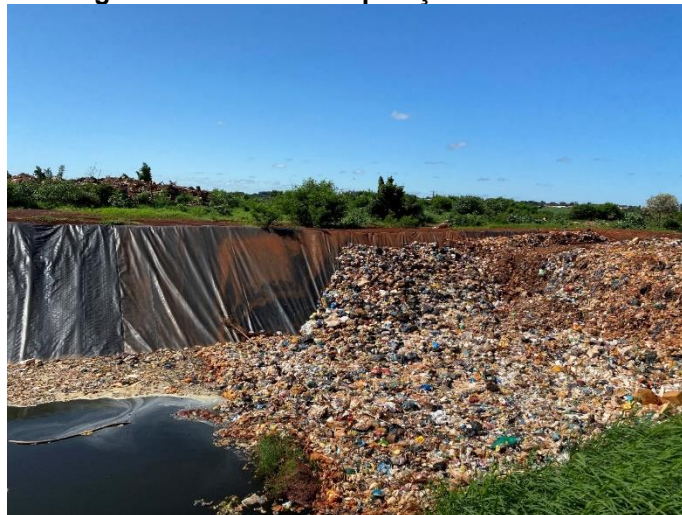
Figura 116: Vala de Disposição de Resíduos
