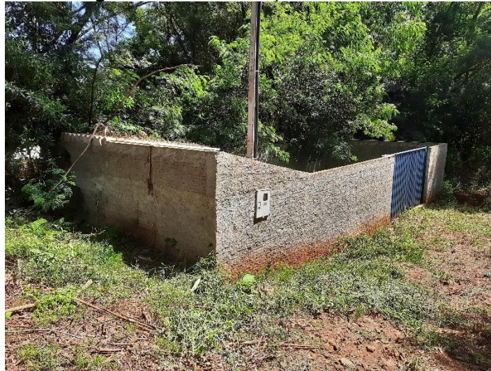
Figura 60: Área do Poço Idimão Simão.
