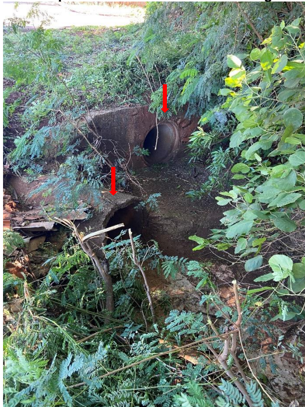
Figura 95: Exemplo de estruturas de microdrenagem - Galerias
