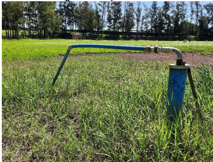
Figura 75: Poço Vila Rural.
